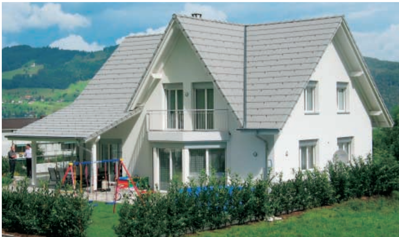
Dem geräumigen Einfamilienhaus in Beckenried sieht man von aussen nicht an, welche raffinierte Technik drin steckt.
